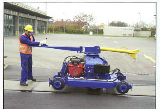
Aufgleisen im niveaubenen Bereich
